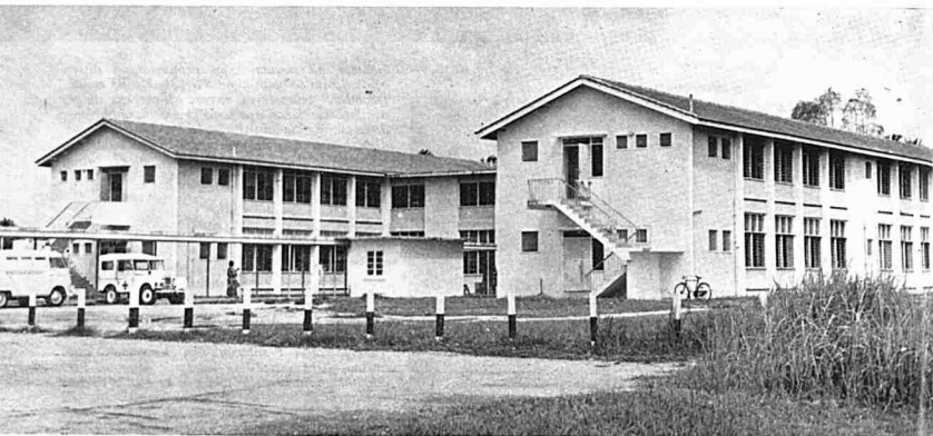
Bangunan baharu Wad2 di-Rumah Sakit, Kuantan.
